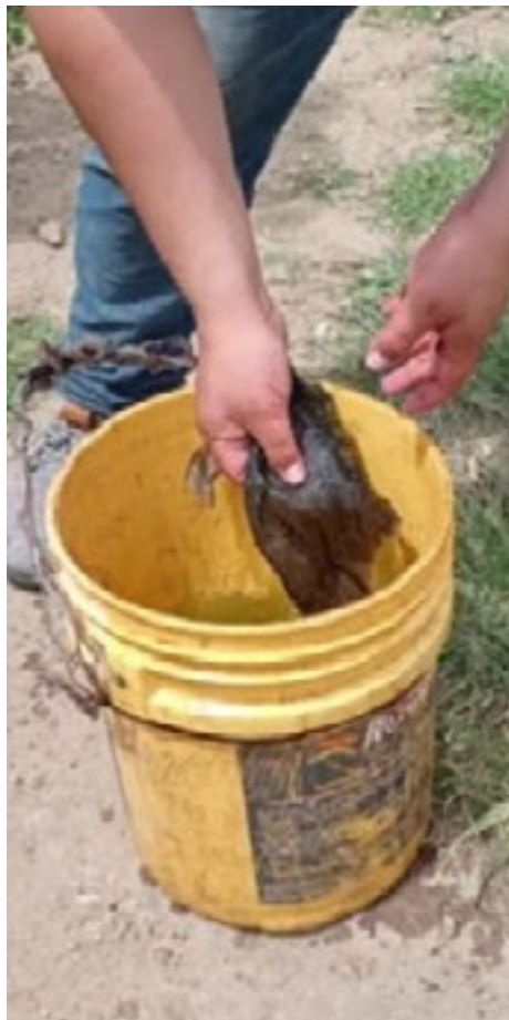
Ilustración 11: LIMPIEZA DE LA TUBERIA DEL REGISTRO
