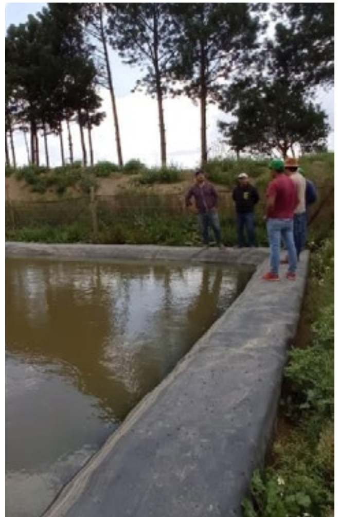
Ilustración 23: GEOMEMBRANA CON ANDADOR
