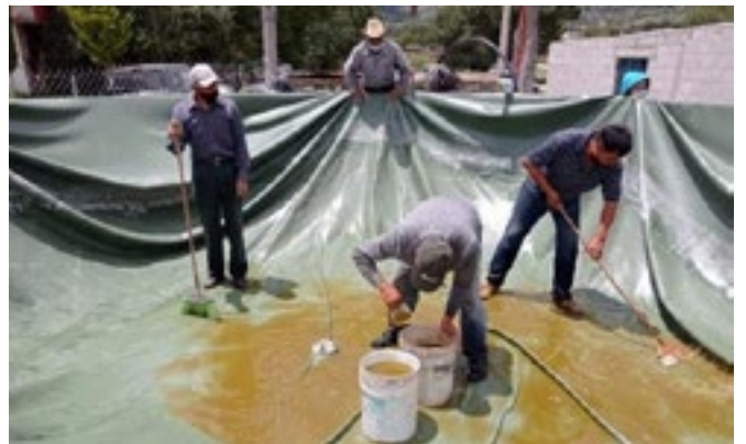
Ilustración 8: LIMPIEZA DE GEOMEMBRANA
