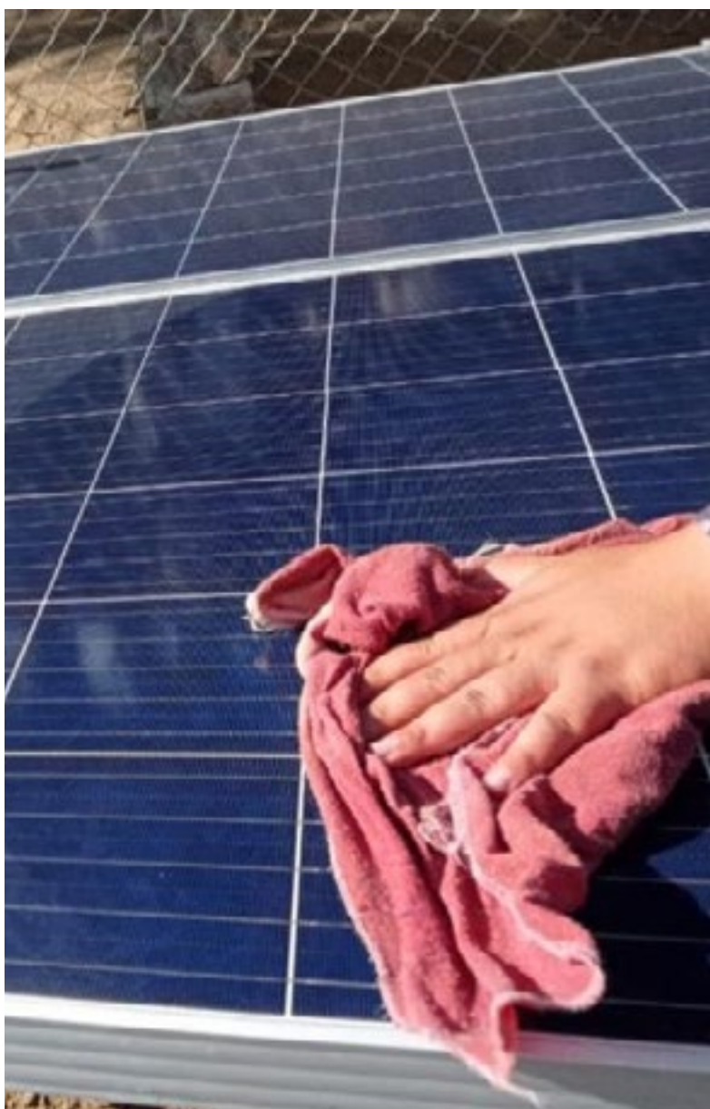
Ilustración 1: LIMPIEZA DEL PANEL
