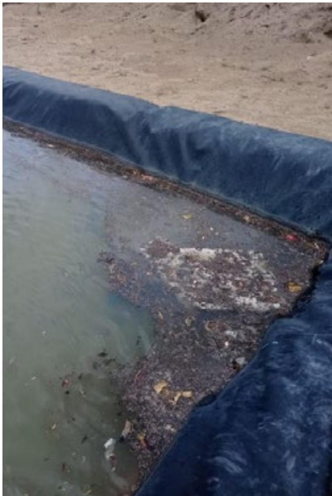
Ilustración 22: GEOMEMBRANA A RAS DE PISO
