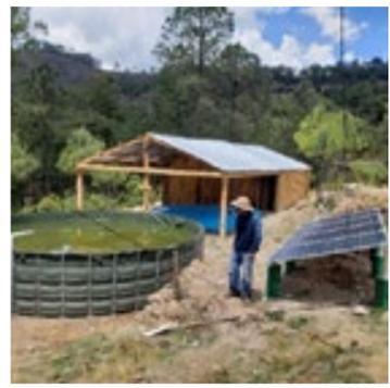
Ilustración 9: Reservorio con geomembrana.
