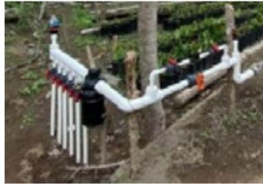
Ilustración 12: Instalación de un cabezal de riego.
