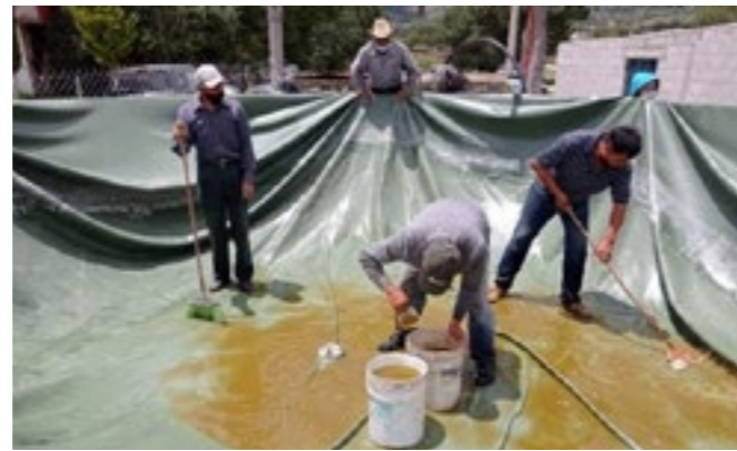
Ilustración 8: LIMPIEZA DE GEOMEMBRANA
