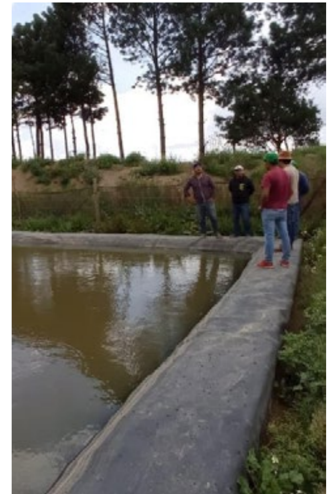
Ilustración 23: GEOMEMBRANA CON ANDADOR
