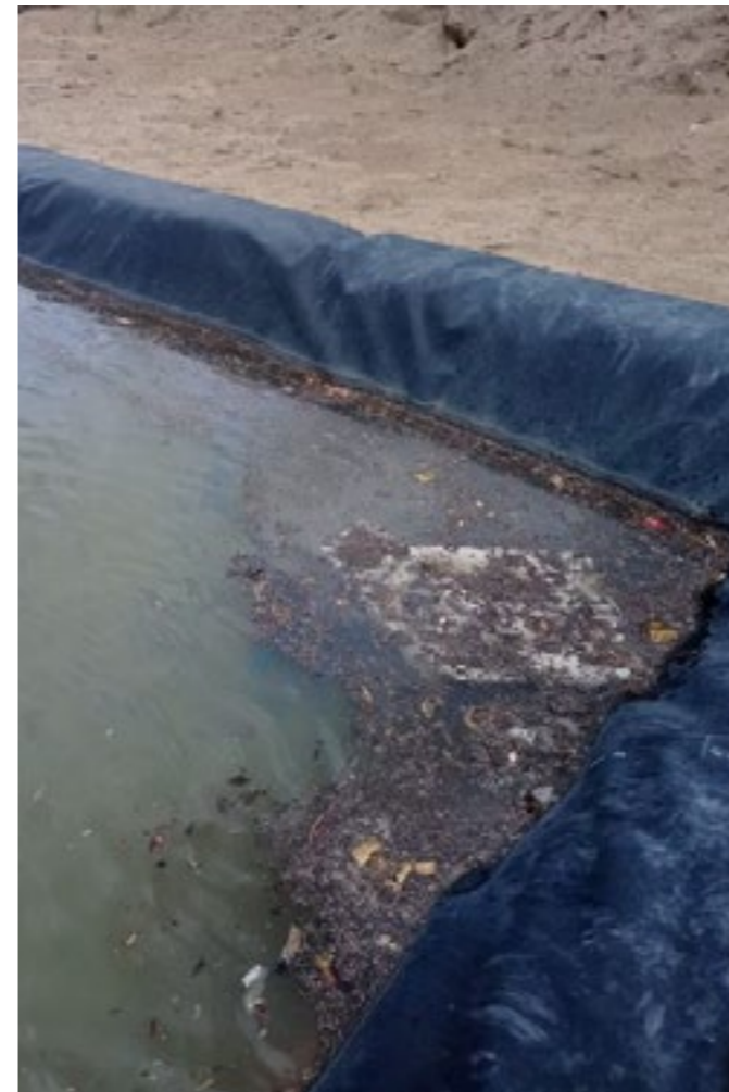
Ilustración 22: GEOMEMBRANA A RAS DE PISO
